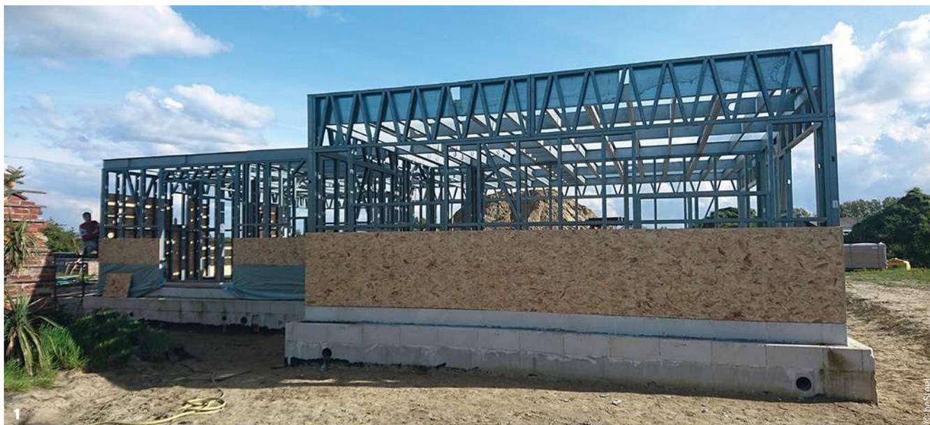
**1 / 2** / Après le montage, l'ossature est pourvue des équipements techniques et remplie d'un isolant souple. Des panneaux d'OSB la referment ensuite de part et d'autre. **3** / Cette méthode légère et flexible a permis d'ajouter pas moins de quatre niveaux à ce bâtiment existant, tout en respectant l'architecture d'origine.
