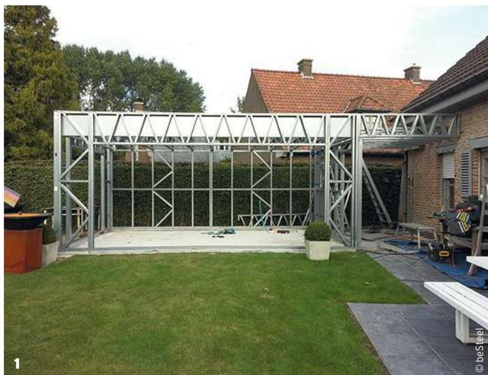
**1 / 2** / La possibilité d'assembler les profilés sur chantier a permis de construire une extension à l'arrière de cette maison sans amener d'engins lourds dans le jardin. Une fois les parachèvements réalisés, on ne voit plus qu'il s'agit d'une construction en acier. **3** / Pour libérer davantage d'espace, il s'avère parfois intéressant de combiner l'ossature avec une charpente métallique traditionnelle.
