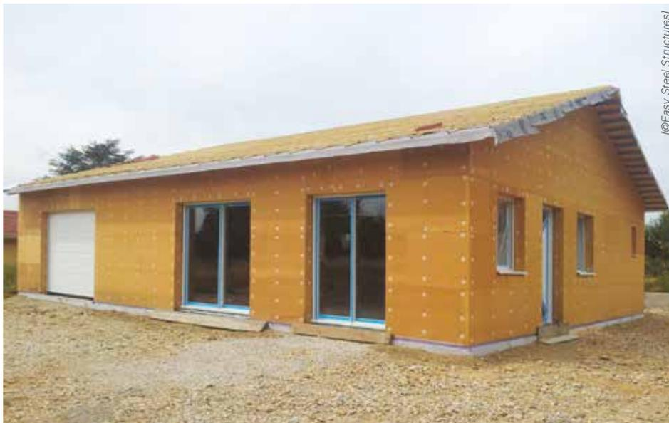
plâtre, le plénum étant rempli d'un isolant fibreux, ce qui permet de rester sur la filière sèche. Les cloisons séparatives intérieures, montées sur profilés métalliques, reçoivent également dans leur épaisseur un isolant fibreux, pour assurer un confort suffisant au sein d'une même maison ou d'un appartement.
